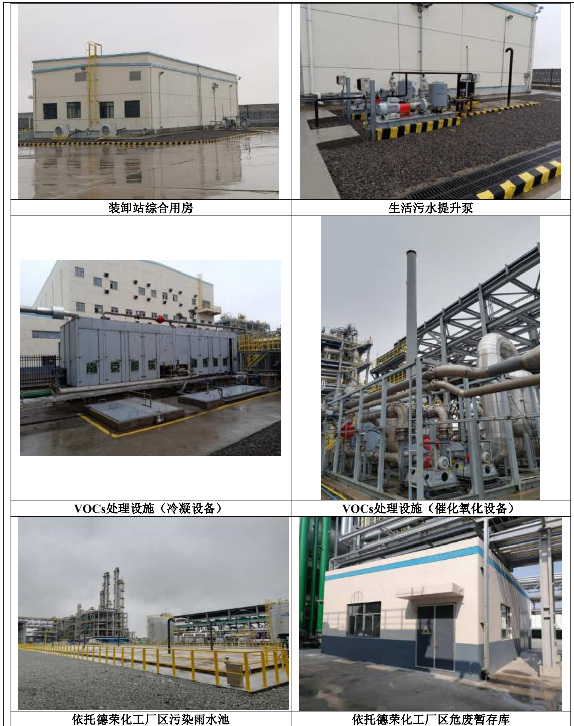
图 2-5 项目建设内容现状照片
